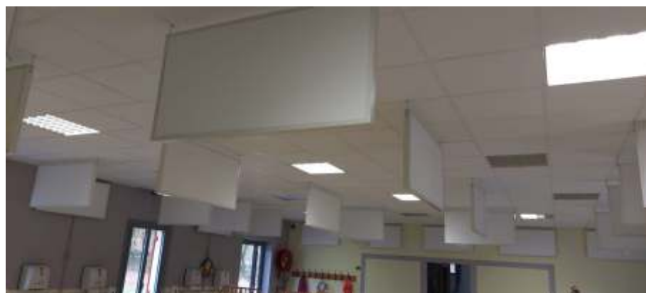
Isolation phonique de la cantine.
